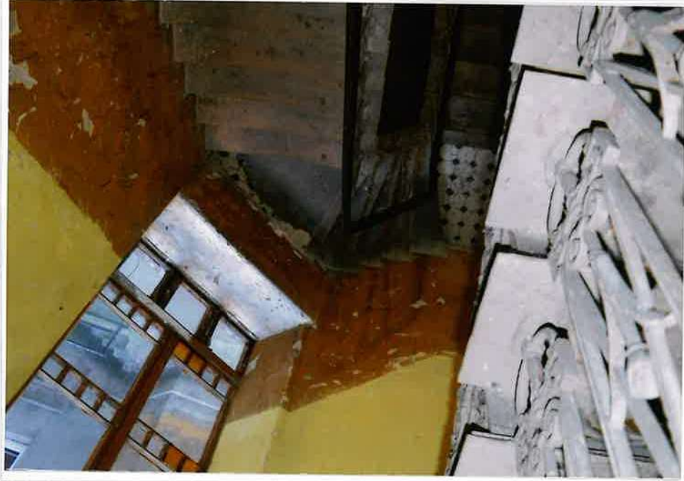
Fot. 10. Budynek narożny, zachodnia klatka schodowa, widok na półpiętro.
