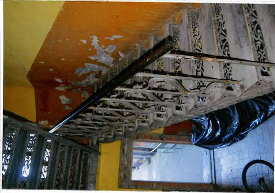
Fot. 11. Budynek narożny, południowa klatka schodowa, pierwszy bieg.
